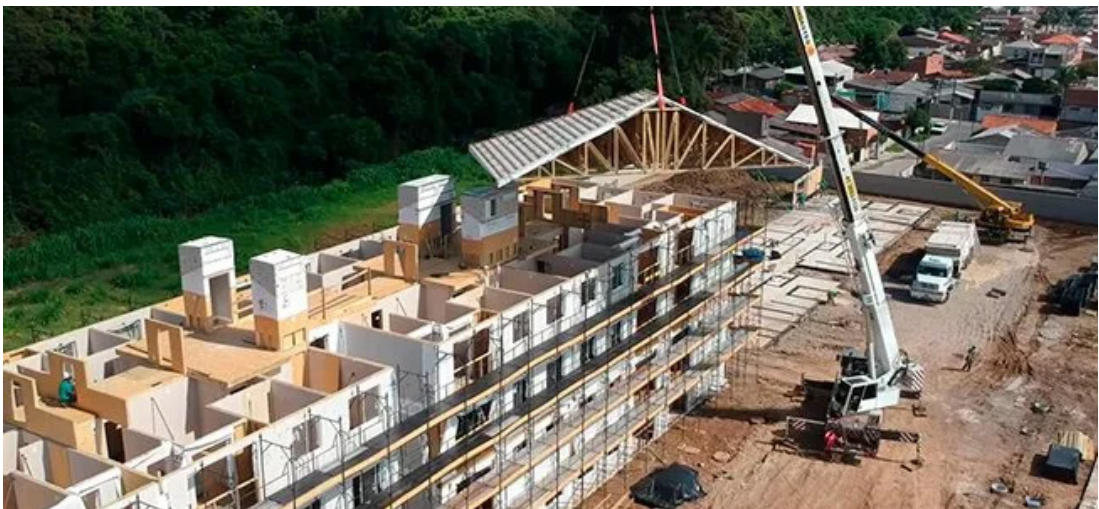
FIGURA 4 — Sistema construtivo light wood frame
